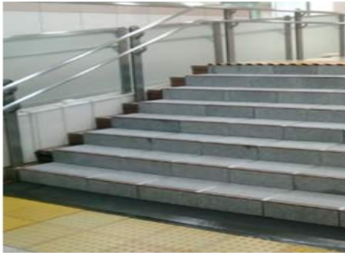
写真 6 実証試験 3 試験状況(階段)
