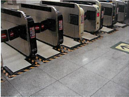
(c)2008年東京駅での床発電実験. 床発電総面積が94 m 2 . 平日1日平均が500 kWの発電量.
