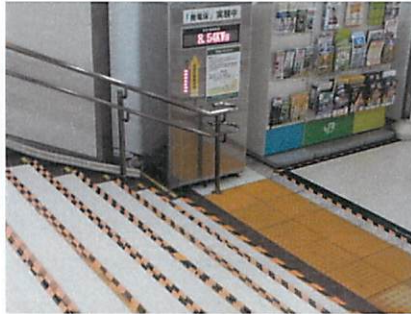
(c)2008年東京駅での床発電実験. 床発電総面積が94 m 2 . 平日1日平均が500 kWの発電量.
