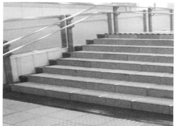
図9 実証試験3の状況（階段）
